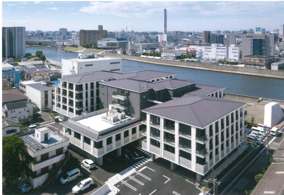
足立区の中学校跡地に建設。河川氾濫時に備えて1階RC部分の階高を通常より高く設計し、さらに平時は機能維持訓練に利用する5階の多目的ホールを2階入所者の避難場所とするなど安全確保の計画も練られている。「都市型中層木造建築として、木材を多用しながらあえて木造らしさを消した挑戦」と評価され、第5回COFI木造建築デザインアワードを受賞した。
