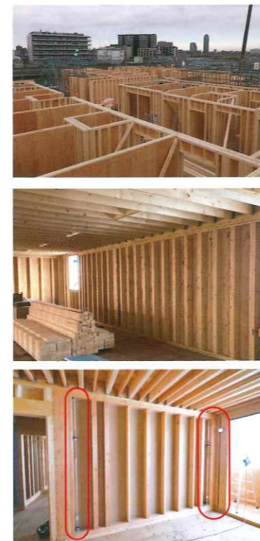
2～5階の4層はツーバイフォー1時間耐火構造。
